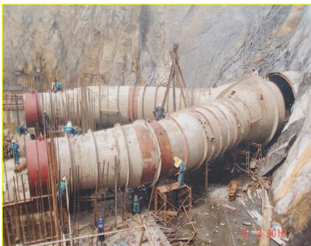
Hình 6.9. Lắp đặt đường ống áp lực
