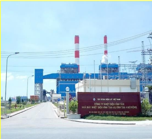
Hình 6.1. Nhà máy nhiệt điện
