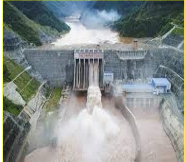
Hình 6.2. Nhà máy thủy điện
