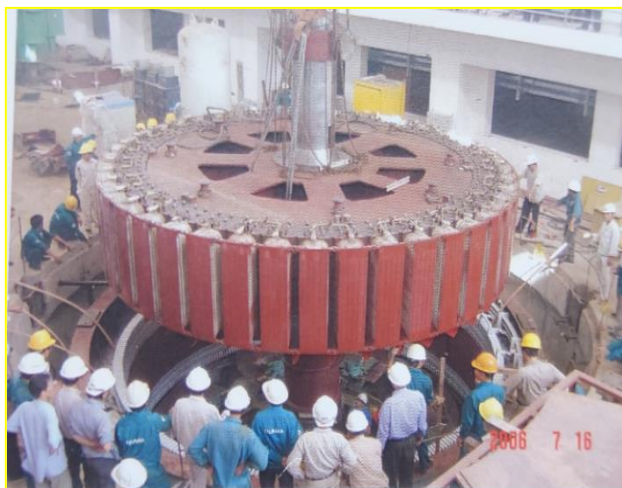
Hình 6.8. Lắp đặt roto tổ máy
