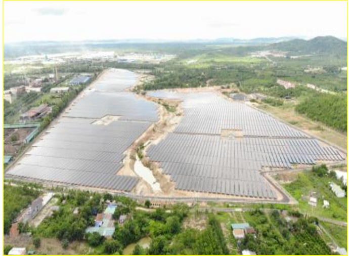
Hình 6.13. Nhà máy điện mặt trời Trúc Sơn (Cư Jút, Đắk Nông)
