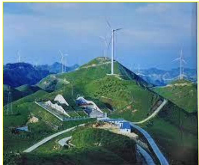
Hình 6.4. Trạm phát điện năng lượng gió
