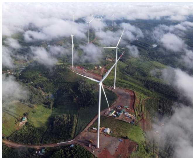
Hình 1.9. Dự án điện gió Nam Bình 1 tại xã Nam Bình, huyện Đắk Song (Nguồn: Thông Tấn xã Việt Nam)
